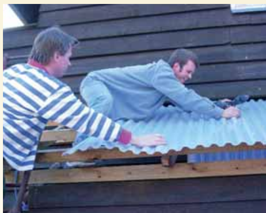
Duschtaket byttes av Daniel Johansson (paddlare sedan 3 år tillbaka) och Michael Nordh (nybliven paddlare). Några takpannor hann de också med att byta ut.
